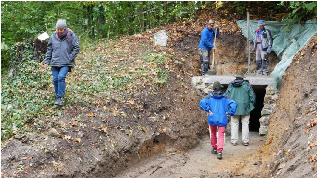
Abb. 13: Arbeitsfoto S 4: Aufmauern des neuen Zugangs. Foto: A. Jäger 07/10/2019
