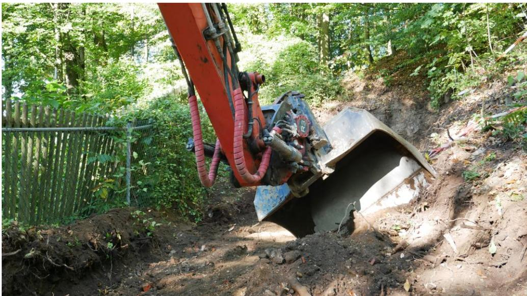
Abb. 11: Arbeitsfoto S 4: Schrägen der Seitenwände bzw. Profile. Foto: A. Jäger
